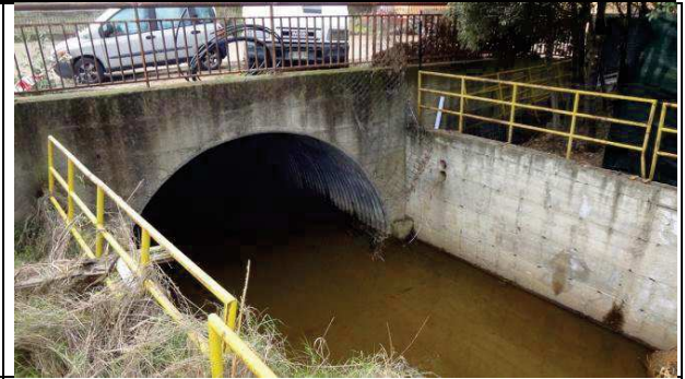
6 Sezione attraversamento via Stromboli lato valle da Dx Ripresa del 19/11/2013. Per gentile concessione del Dott. F. Dore
