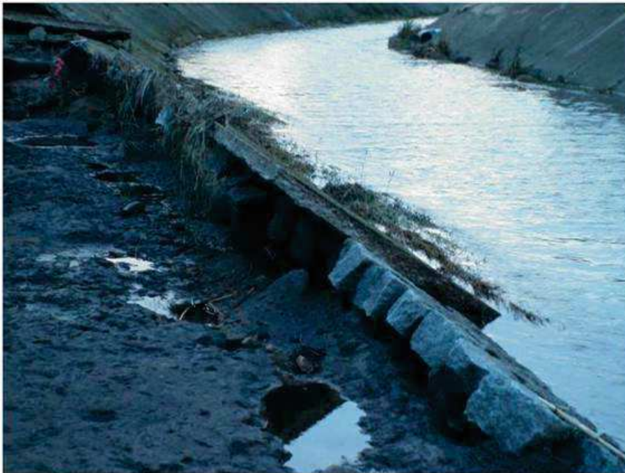
17 - Particolare sponda Dx canale erosa da tergo per trascinamento da esondazione (vista verso monte) con difese spondali di varie epoche sovrapposte
