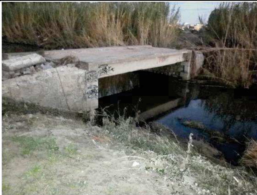
20 - Ultimo ponticello verso valle a monte del ponte ferroviario (visto da Sx, da monte)
