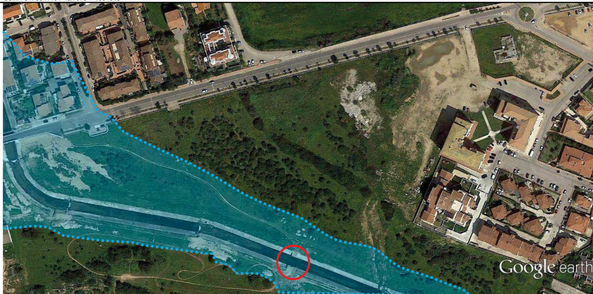
7- Ricostruzione tratto a valle del ponte di via V, Veneto. La corrente provoca più danni a Dx che non a Sx. Il ponticello evidenziato è stato abbattuto nei giorni seguenti all'alluvione. La velocità tende incrementare anche per effetto delle rampe (n.3 nel solo tratto in foto)
