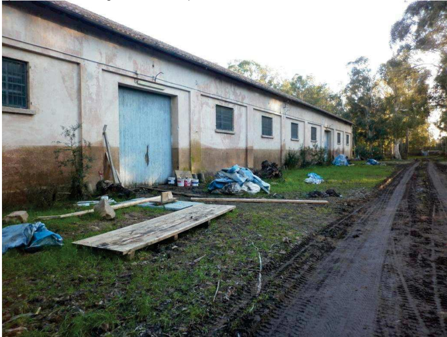
22 - Segni stazionamento tiranti idrici a +1,60m nell'area ex artiglieria in sponda Sx S'Eligheddu
