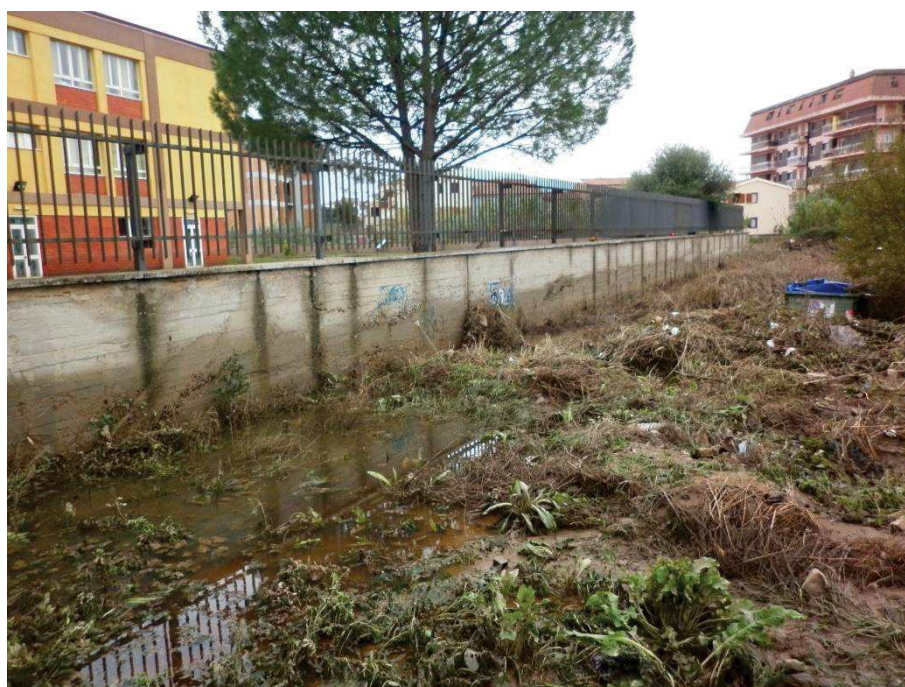
Fig. 11 - Muro di recinzione della Scuola elementare di Santa Maria con tracce evidenti dei livelli di stazionamento
