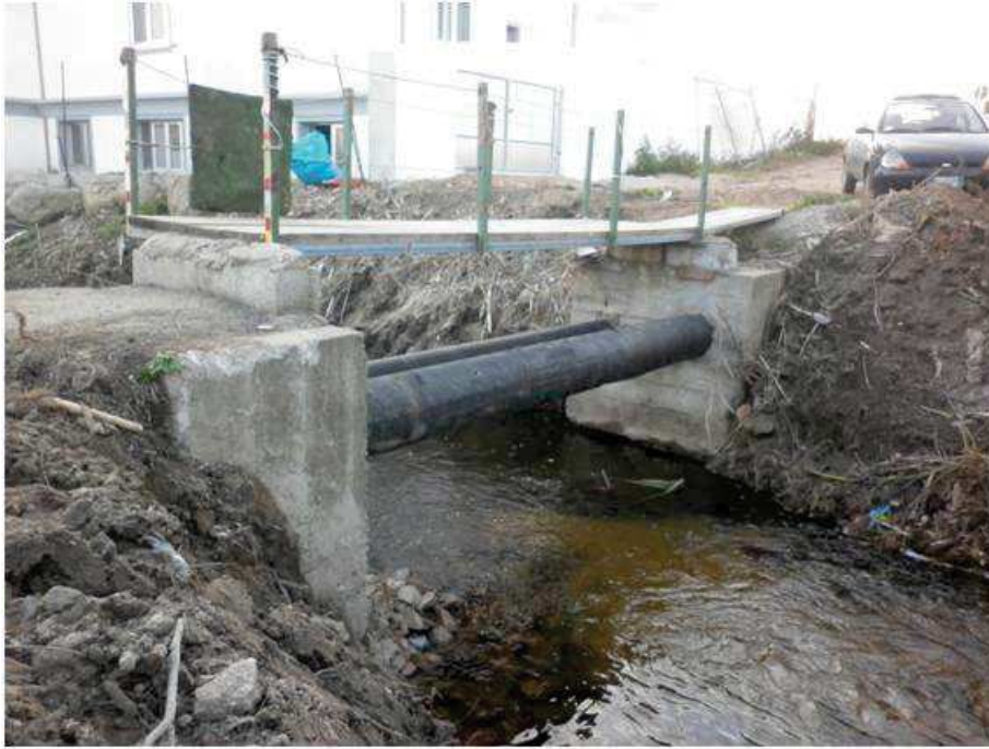
Fig. 13 - Condizione in prosecuzione di via Fara (vista da monte a Sx)
