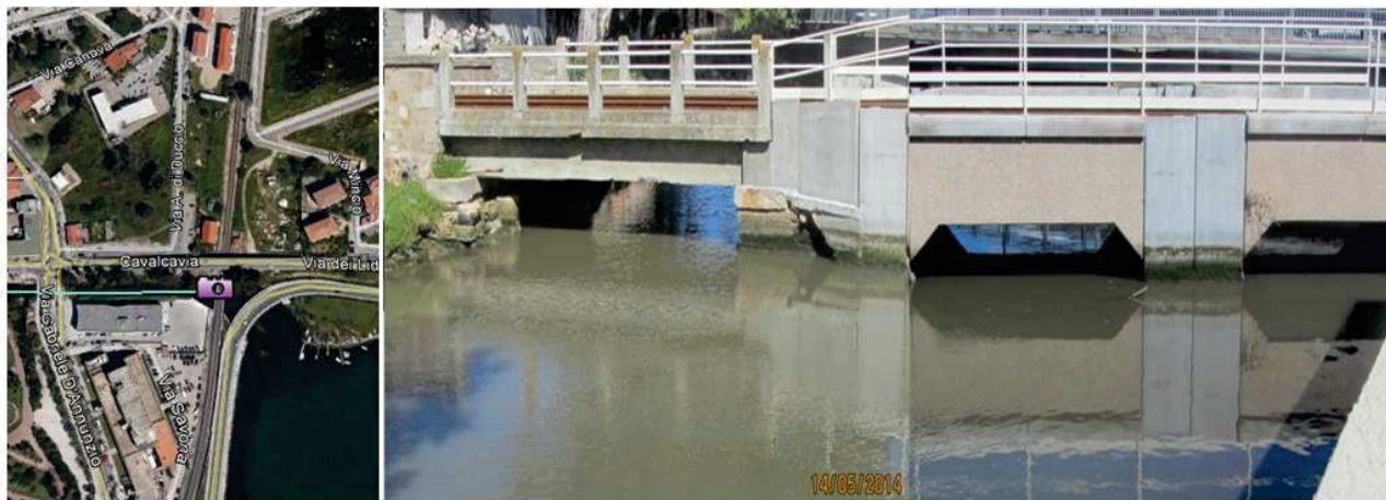
Figura 48. Attraversamento ferroviario in prossimità della foce del Riu San Nicola.
