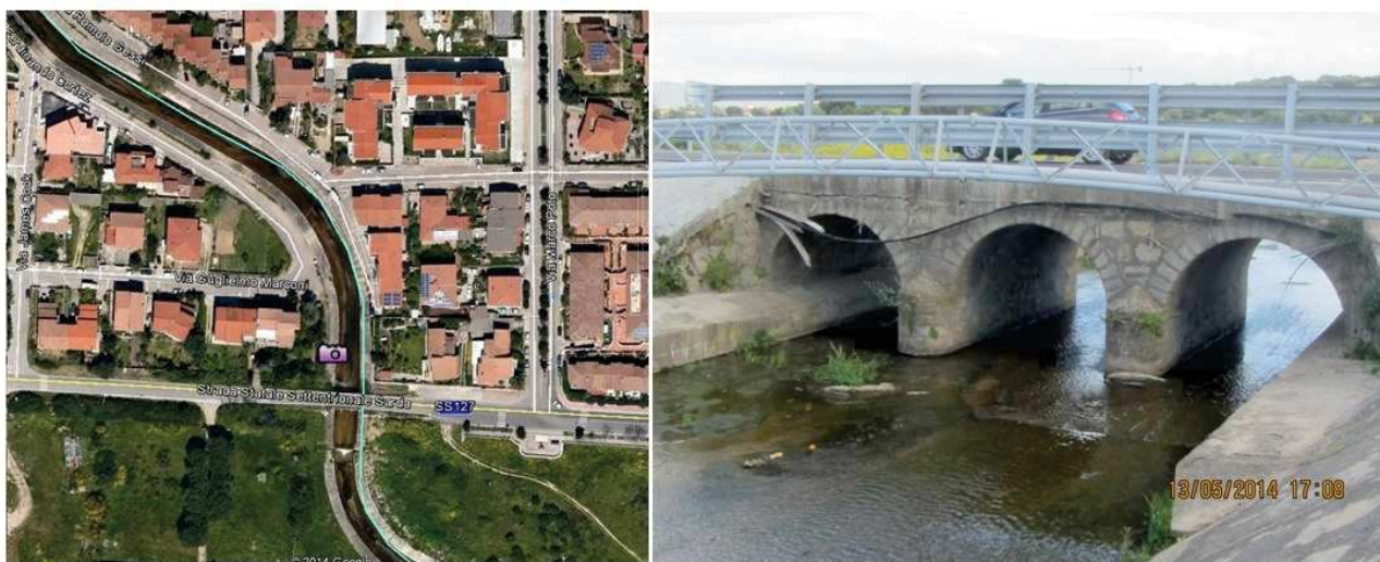
Figura 41. Ponte di Via Veneto (SS127) Riu Seligheddu - L’impalcato è posto all’interno della sezione, con tre luci ad arco di facile ostruzione. Vista da monte verso valle.
