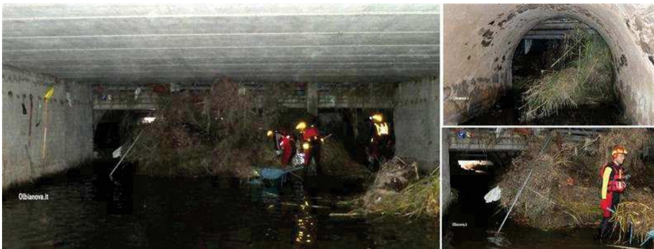
Figura 40. Otturazione nei pressi della rotonda di Via Umbria. Si può notare l’ostruzione avvenuta durante l’alluvione del Novembre 2013 (Fonte Olbianova.it).
