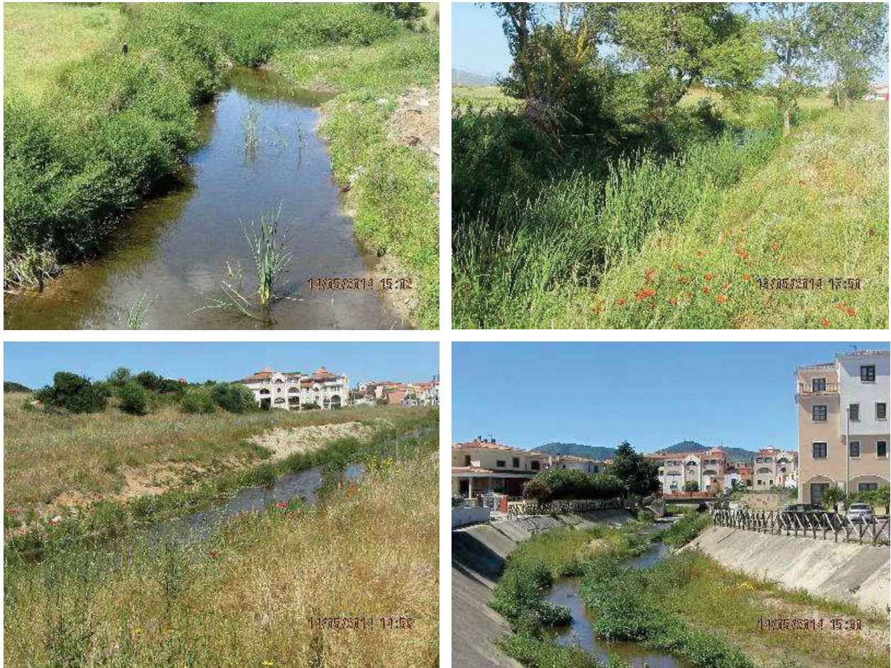
Figura 20. Situazioni tipiche riscontrate, da sinistra verso destra e dall'alto verso il basso: impluvio, caratterizzato da sezioni non incise e dalla presenza di vegetazione; situazione intermedia tra impluvio e canalizzazione, caratterizzato da sezioni mediamente incise e presenza di vegetazione; canalizzazione tipo 1 o 2, caratterizzata da sezioni incise e sponde e fondo naturali con presenza di vegetazione; canalizzazione tipo 3, caratterizzata da sezioni incise con sponde e fondo rivestiti con eventuale presenza di vegetazione sul materiale di deposito.
