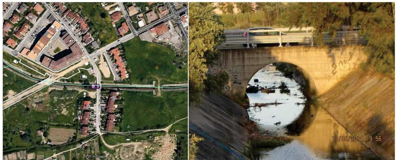
Figura 44. Attraversamento in Via T. Edison – Riu Gadduresu.
