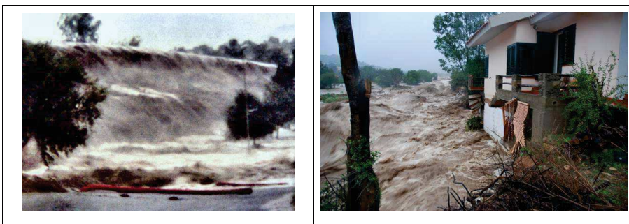
Figura 45 – Le fotografie mostrano i momenti drammatici dell'evento, a sinistra mostra il momento di tracimazione della diga alle 8.00 e a destra la furia dell'acqua tra le abitazioni.
