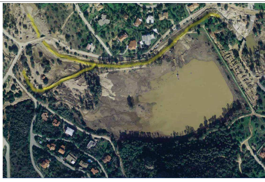
Figura 72 - Canale diversivo e completamento dell'abbassamento del livello del lago q.ta 59. (Foto aerea 6.11.08)
