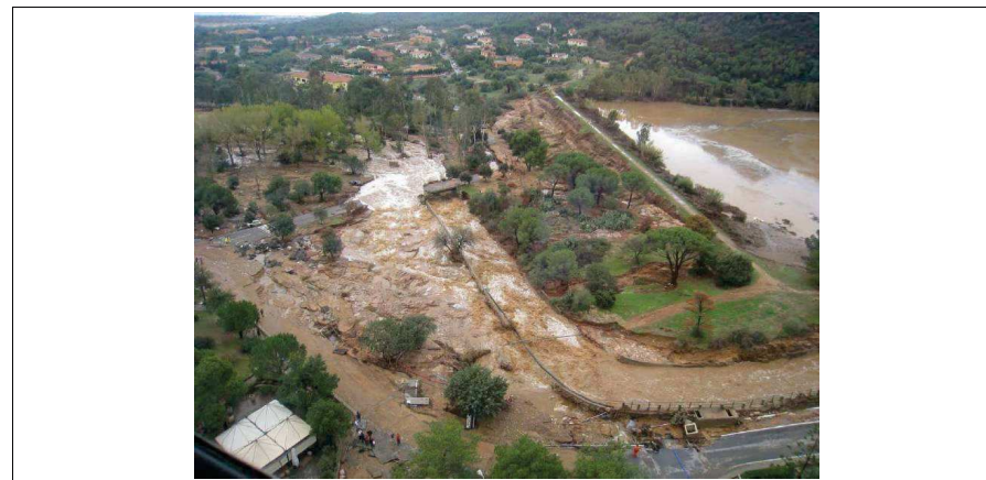
Figura 67 – La foto riporta lo stato delle opere a valle dell'invaso; è evidente la inadeguatezza del canale sfioratore.
