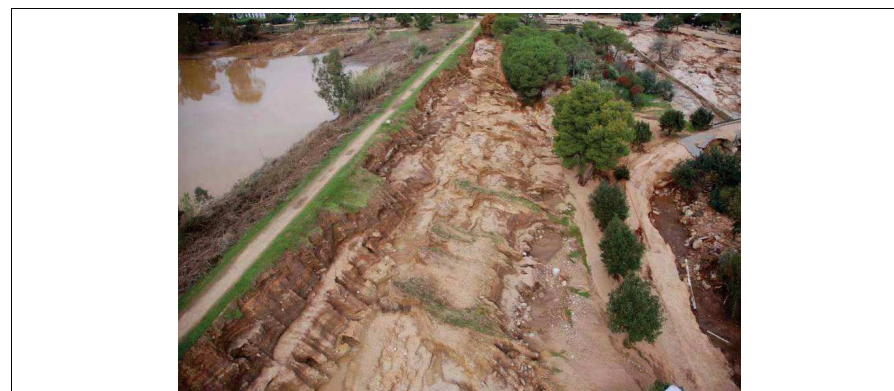
Figura 68 – Stato dello sbarramento il 25 ottobre 2008.
