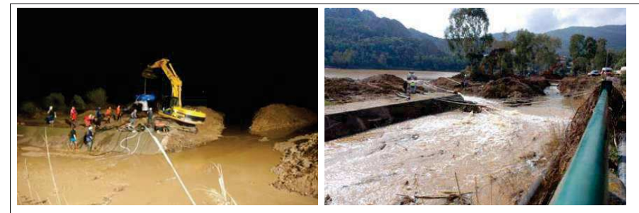
Figura 71 – Abbassamento del livello sotto la soglia sfiorante sino a quota 59 - 25.10.08.
