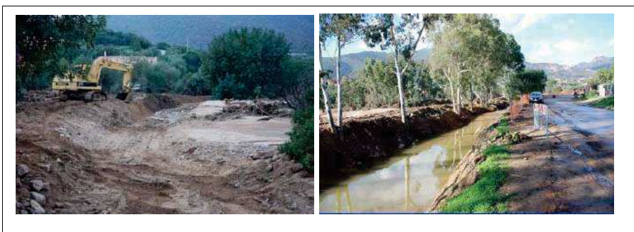
Figura 70 – Realizzazione del canale diversivo.
