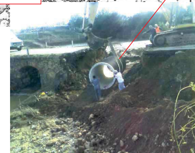
SP 91 - raddoppio della sezione idraulica dell'attraversamento a mezzo di tubazioni di sezione 1600 e 1500 in adiacenza al ponticello preesistente
