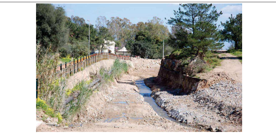
Figura 73 – Lavori sul canale di scolo ultimati.
