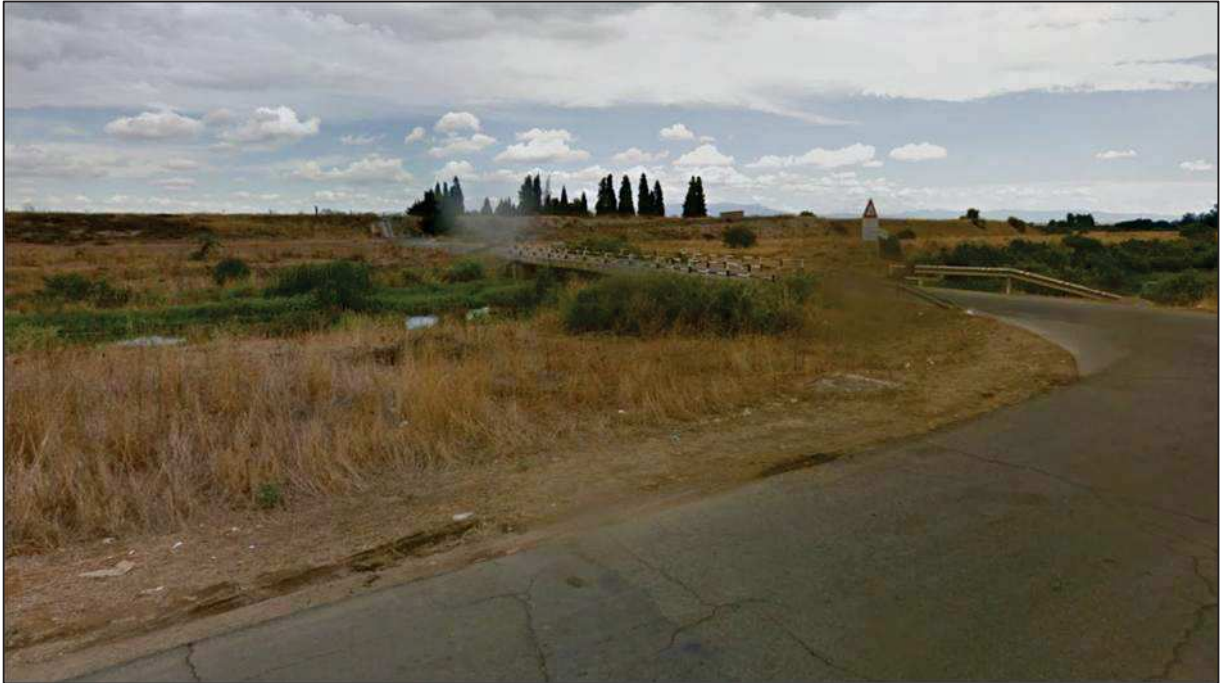
Figura 1.6 – Ponte guado di Via Ponte a Uta
