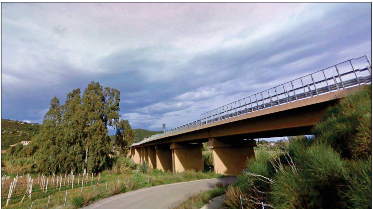
Figura 1.9 – Ponte nuova SS 125
