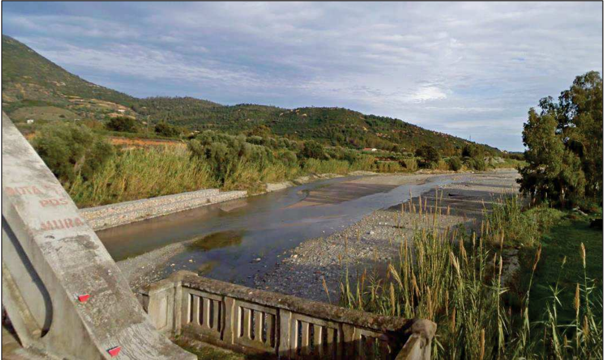
Figura 1.4 – Tratto a valle del ponte San Paolo: difesa spondale dx e sx in gabbioni
