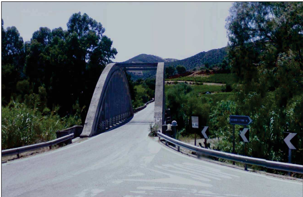
Figura 1.8 – Ponte San Paolo vecchia SS 125
