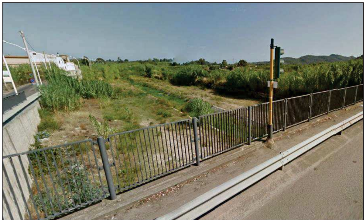
Figura 1.9 – Ponte Via Garibaldi (Ponte di ferro)
