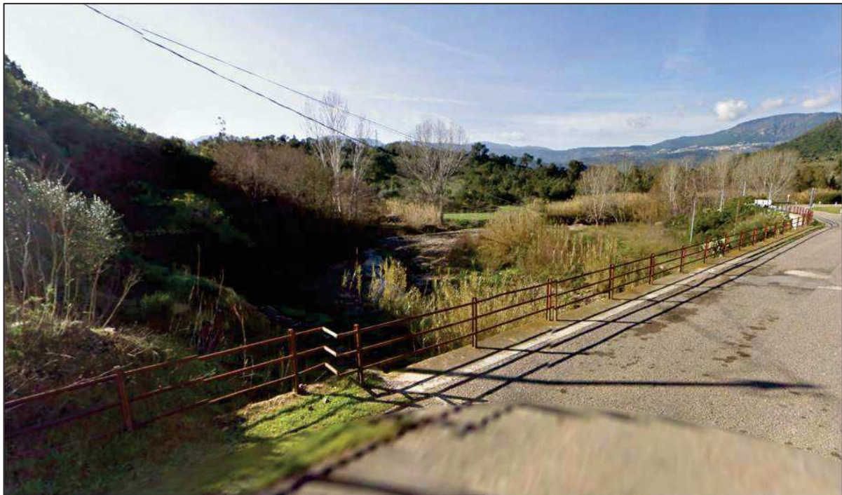
Figura 1.7 – Ponte in località Serra Pellai
