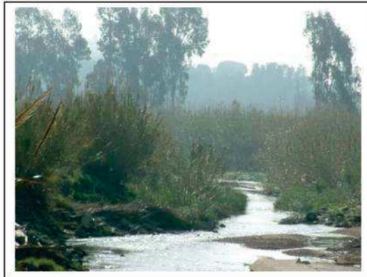
Figura 1 - Immagine rappresentativa del tratto omogeneo 11.
