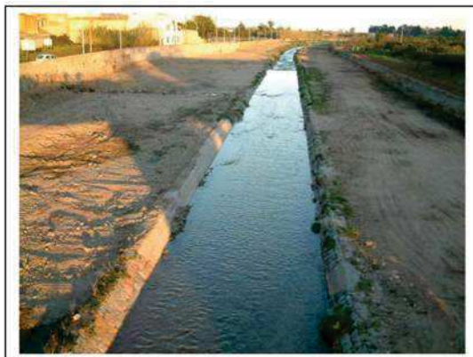
Figura 1 - Immagine rappresentativa del tratto omogeneo 10.
