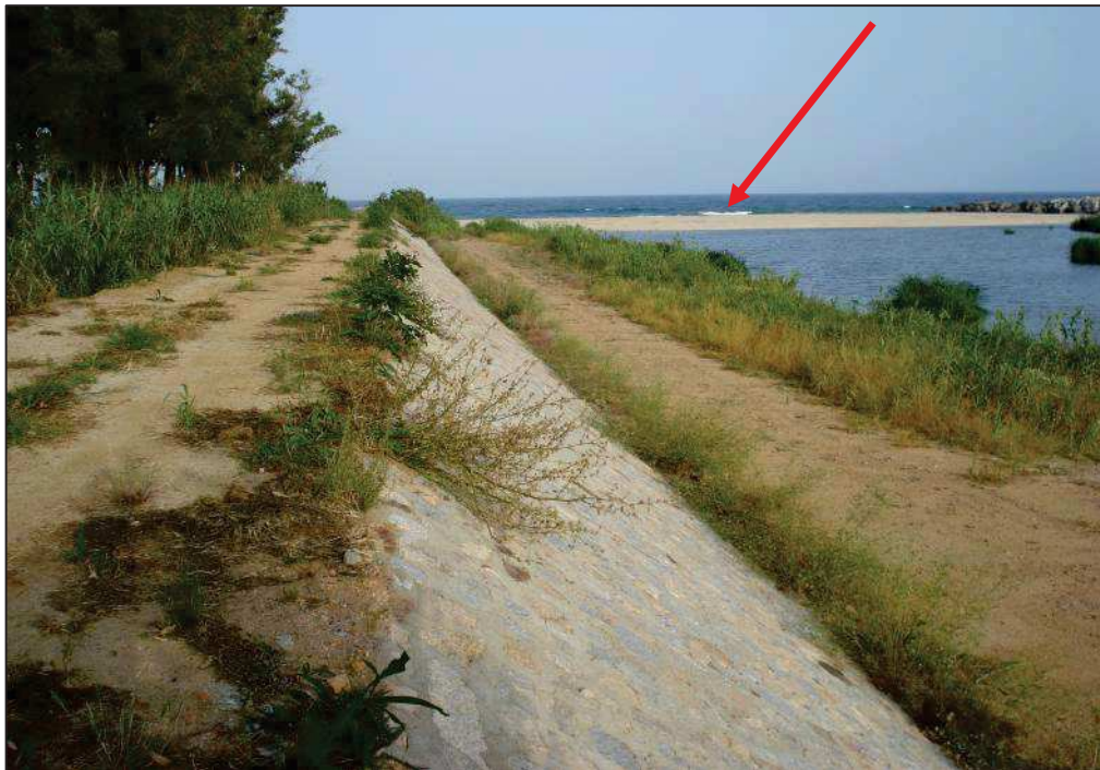
Figura 2.12 – Tratto focivo: argine sinistro in terra rivestito sul paramento interno – visibile la barra dunale;
