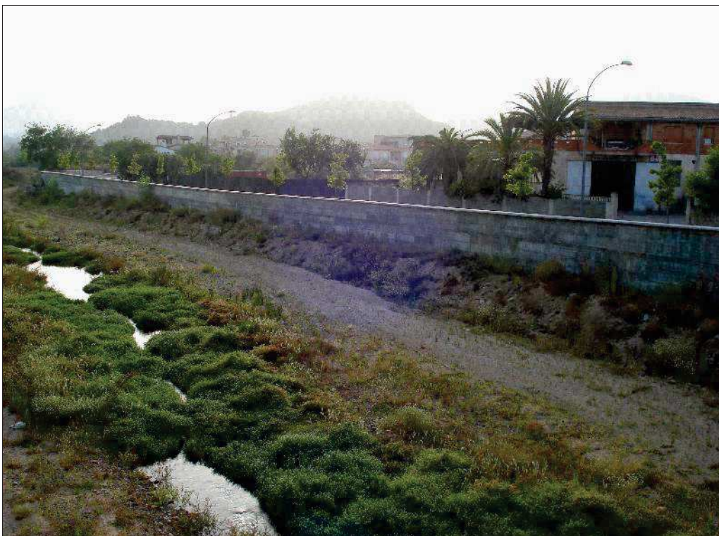
Figura 4.2 –Via delle Lavandaie prima e dopo l'intervento di realizzazione del muro d'argine
