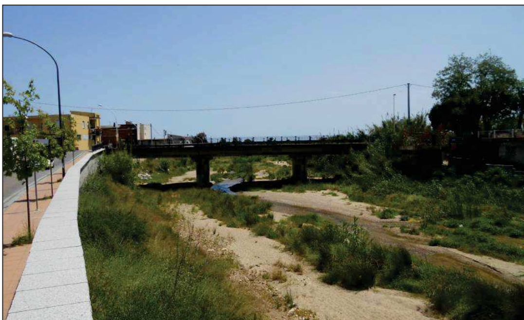
Figura 6.5 – Ponte di ferro in via Garibaldi da demolire
