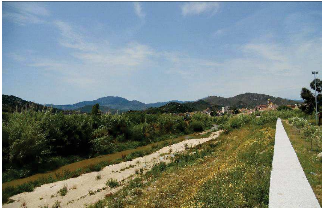
Figura 3.1 – Effetto alluvione 28/11/2008 a valle del ponte di ferro (confronto 2008 – 2012)
