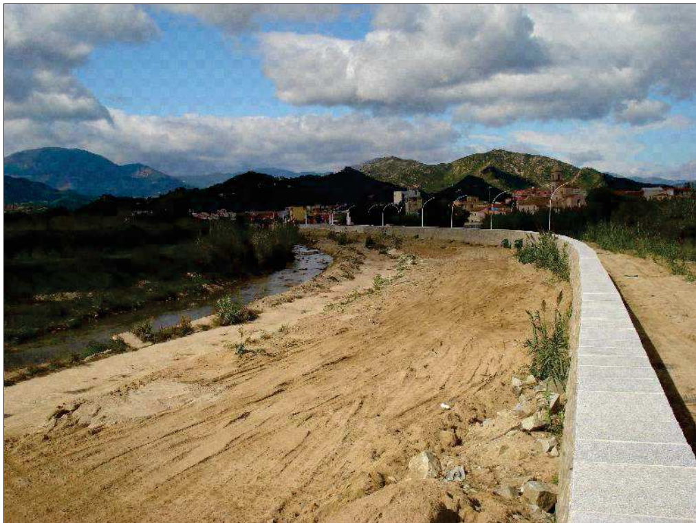
Figura 4.3 – Via Foddeddu prima e dopo l'intervento di realizzazione del ripristino e sovrizzo del muro d'argine
