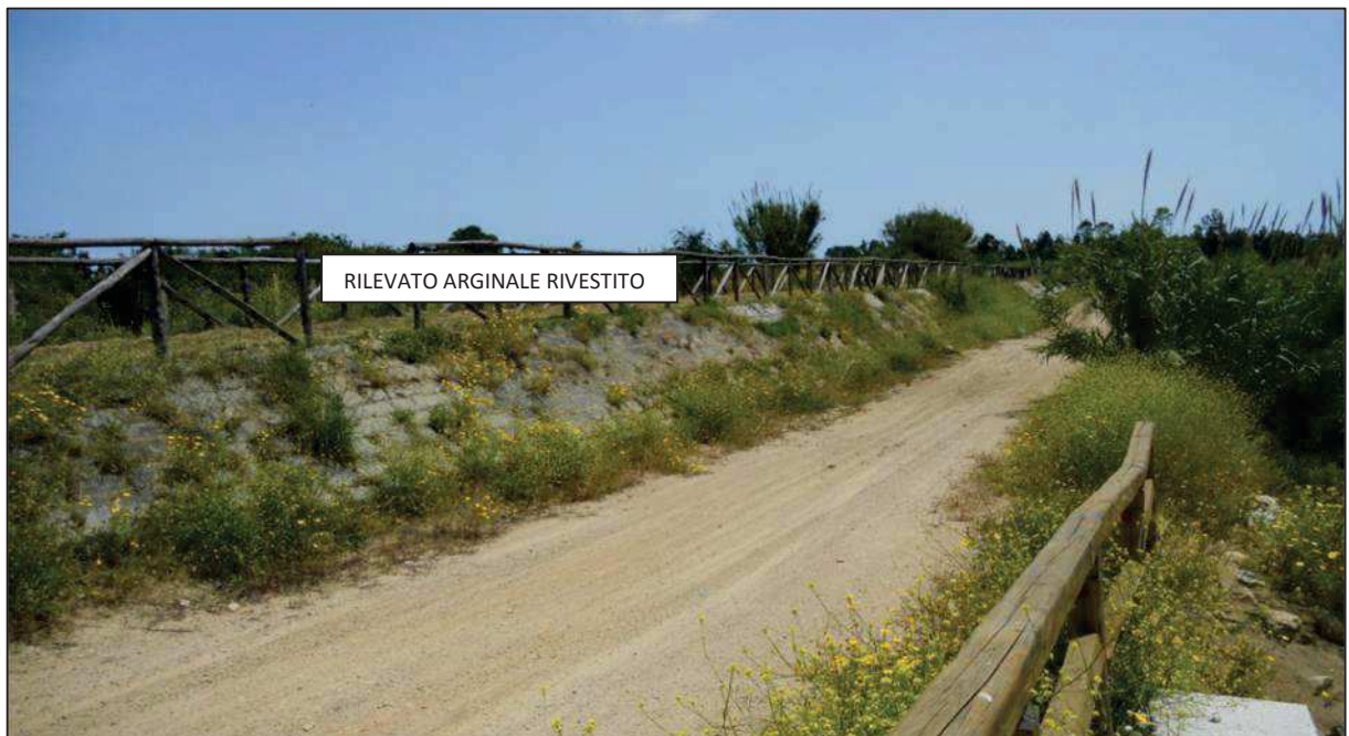
Figura 6.2 – Rilevato arginale sx in terra a valle del ponte di ferro
