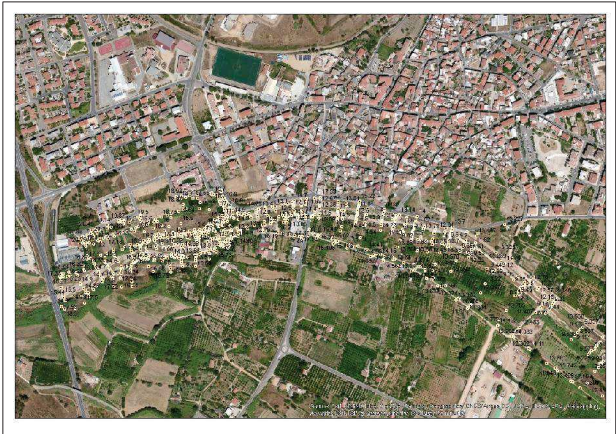
Figura 4.1 –Rilievo di dettaglio alveo a valle della SS 125
