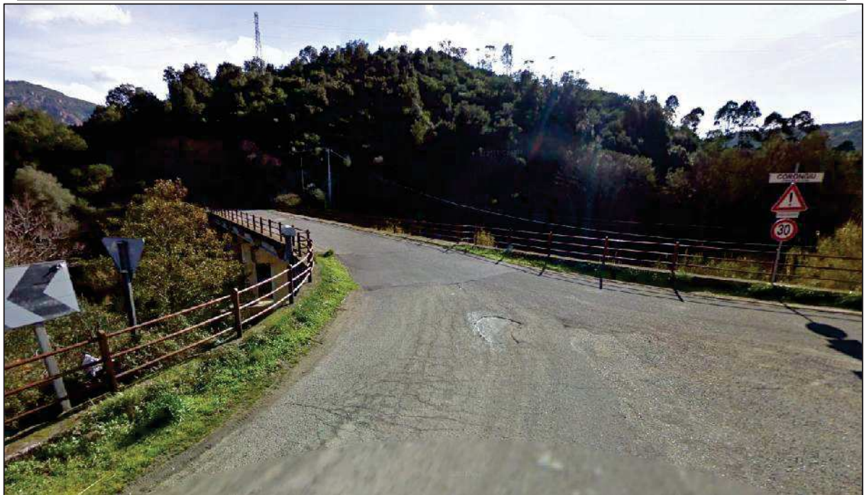
Figura 3.3– Ponte strada vicinale in località Serra Pellai
