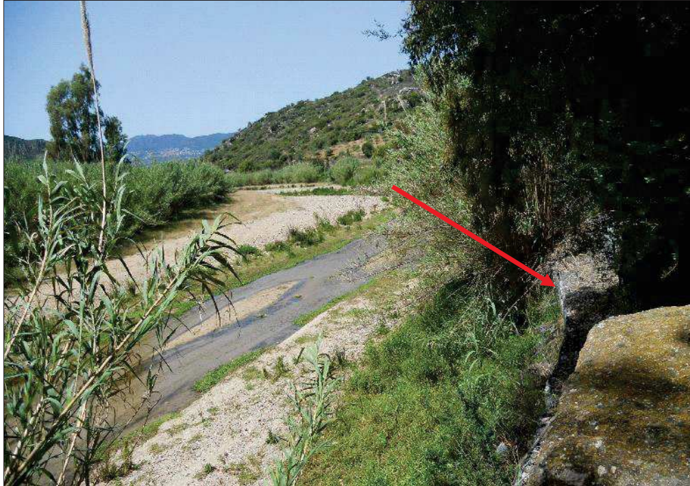
Figura 2.9 – Tratto monte SS 125: difesa spondale sx in gabbioni a protezione della SS 198 in località Tanca Suergiu;
