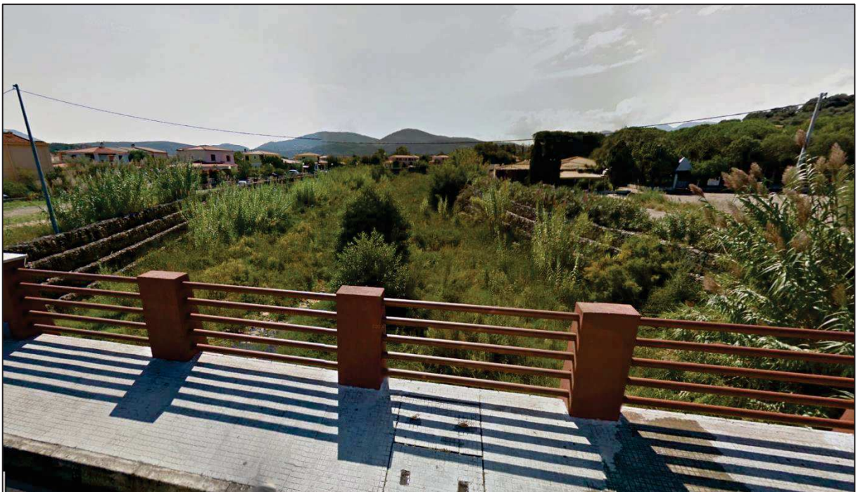
Figura 1.12–Ponte Via Sardegna vista monte situazione anno 2008 - 2016
