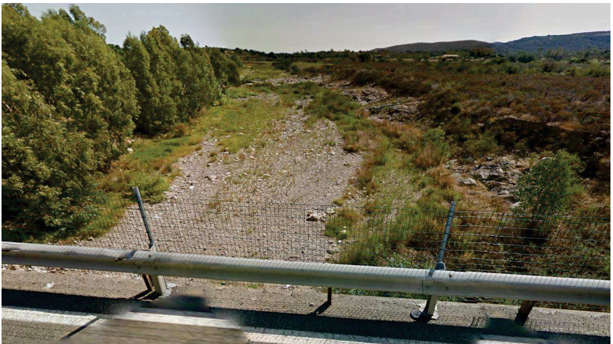
Figura 1.8—Ponte SS 125 vista valle situazione anno 2008 - 2016
