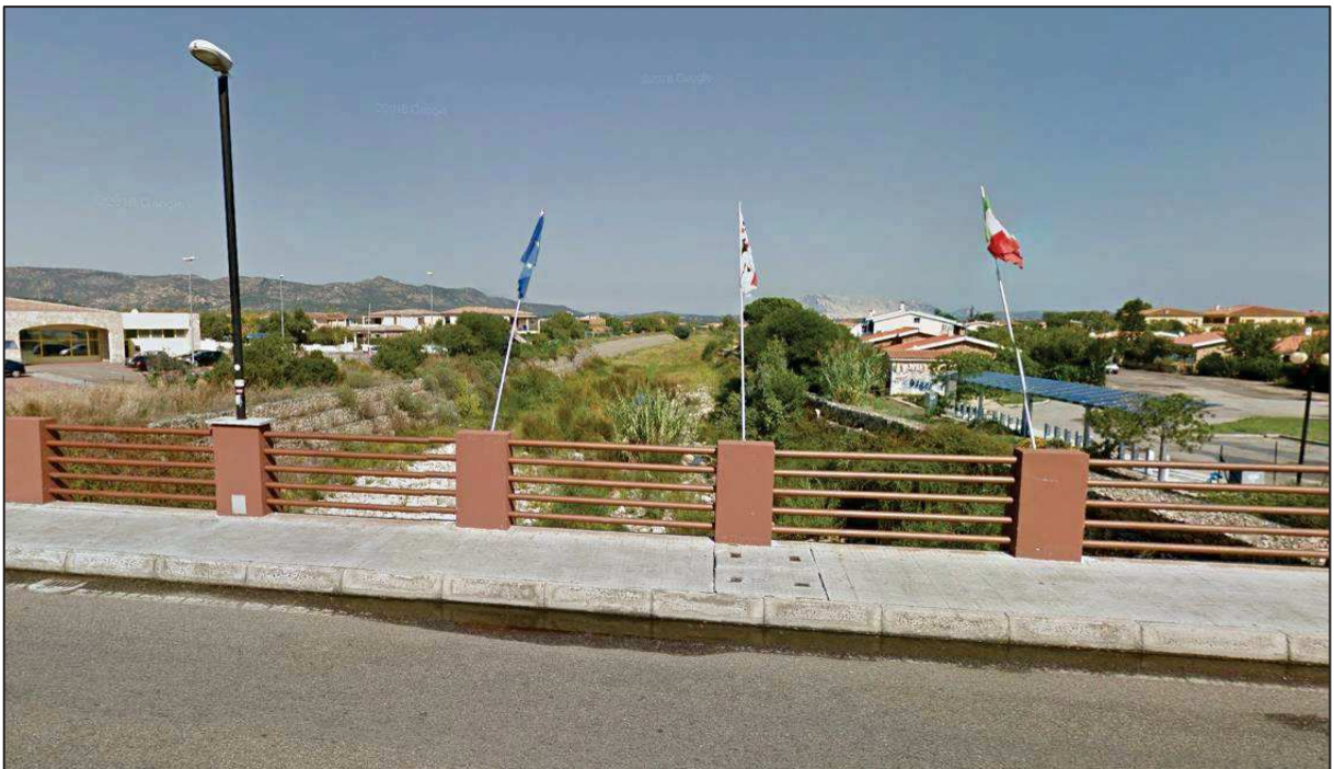
Figura 1.11–Ponte Via Sardegna vista valle situazione anno 2008 - 2016
