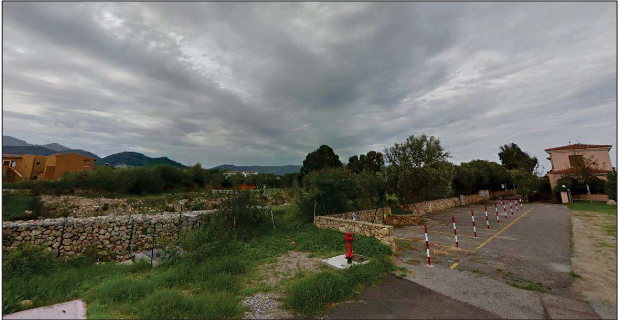
Figura 1.18 – Rialzo della protezione spondale in gabbioni in destra idraulica a valle del ponte di Via Sardegna
