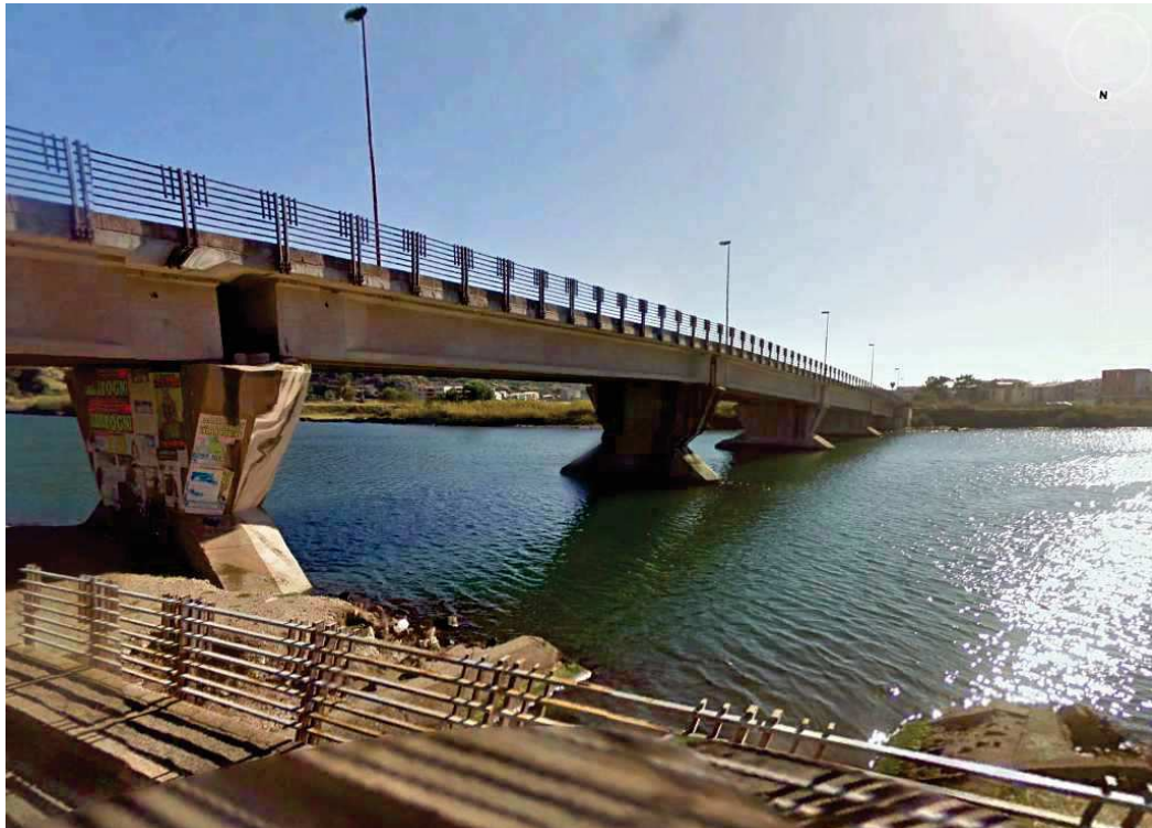
Figura 1.4 – Ponte nuovo SP 49
