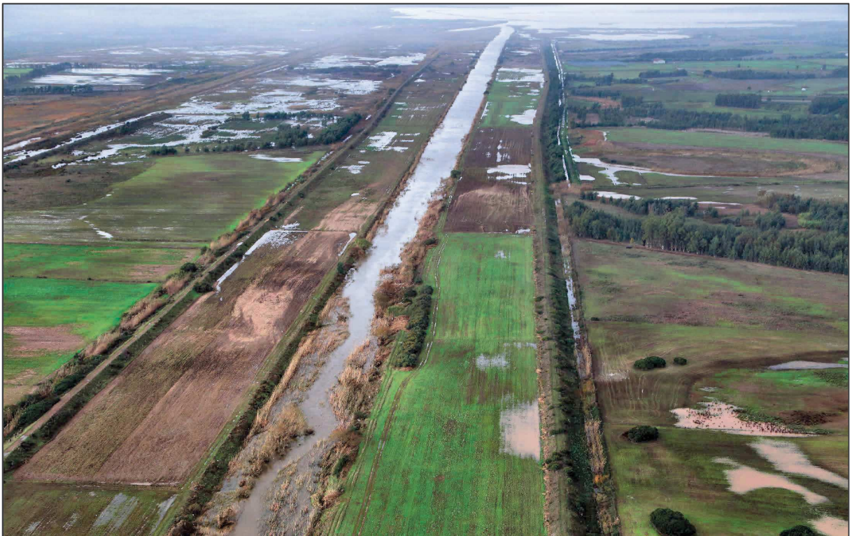
Figura 1 – Fluminimannu di Pabillonis – Tratto arginato di valle (CBSM)
