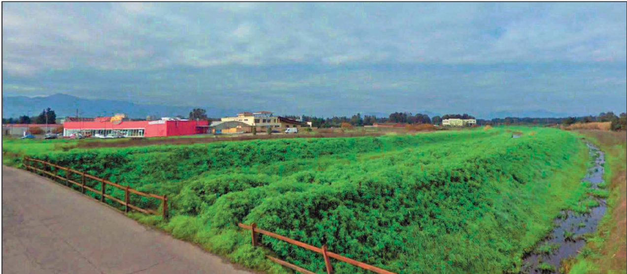
Figura 35 –Ponte “San Gavino Sud” – Vista sul ponte
