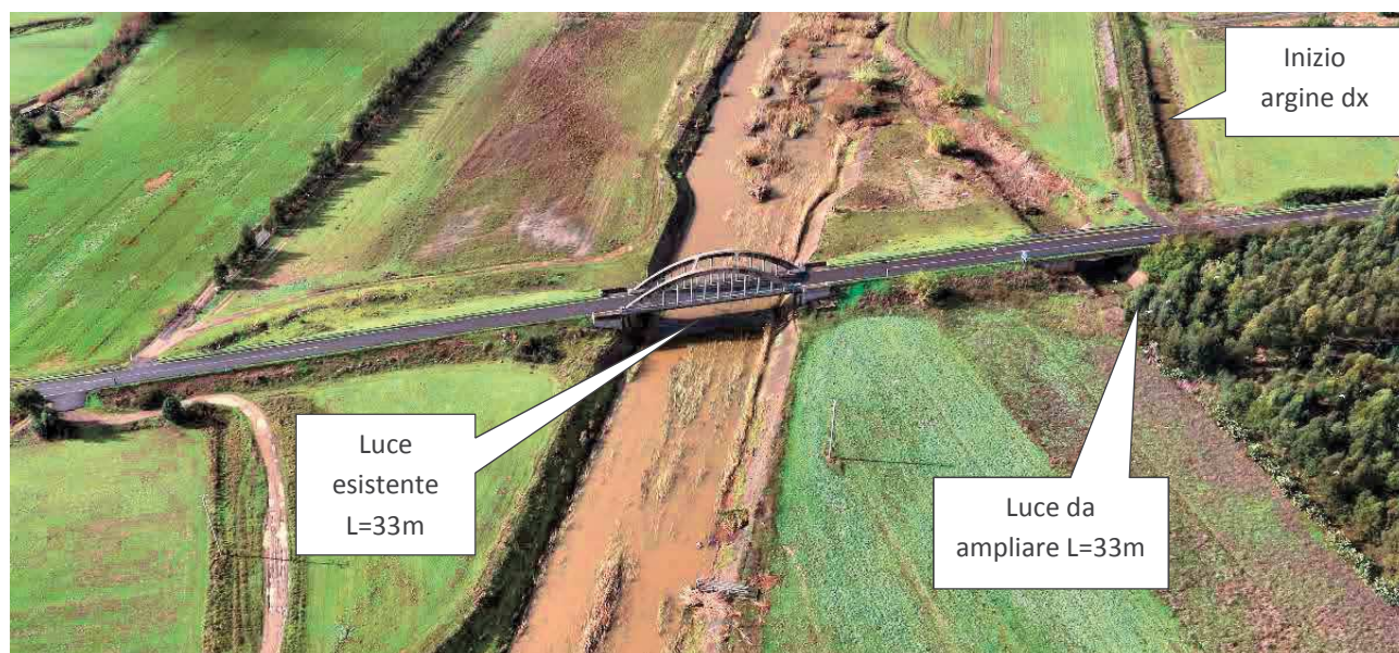
Figura 31 – Ponte della S.S. 126 presso San Nicolò d'Arcidano (CBSM)
