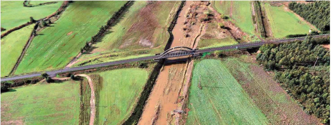
Figura 24 – Ponte sulla S.S. 126
