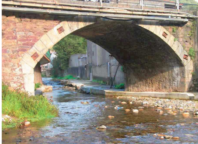
Figura 1.11 – Ponte Via V. Emanuele
