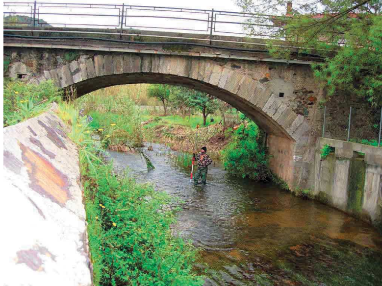
Figura 1.3 – Ponte SS 126 sul Rio Mannu
