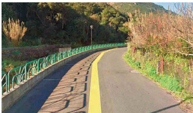
Figura 1.7 – Muretto di recinzione stradale
