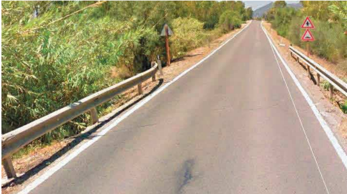
FIGURA 37 LIVELLETTA POSITIVA DALLA QUOTA DI 5.53 M S.L.M (FONTE DTM) ALLA QUOTA DI 7.47 M S.L.M VALUTATA SULL'IMPALCATO STRADALE (FONTE P.S.F.F)
