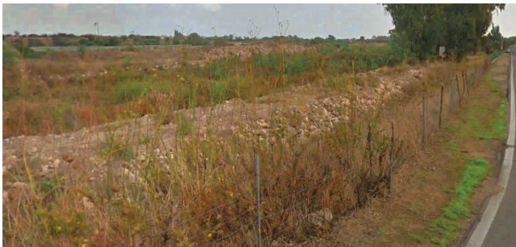
Figura 26 - Arginello in destra idraulica a valle del ponte di via Foscolo
