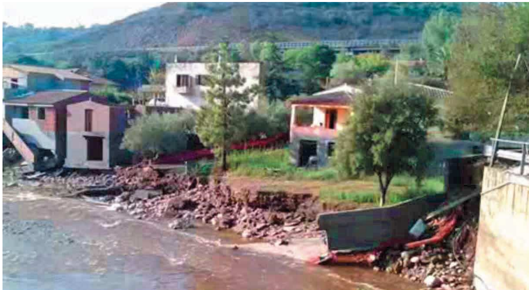
Figura 14 - Danni provocati dall'alluvione del 2010 nella località Berruiles
