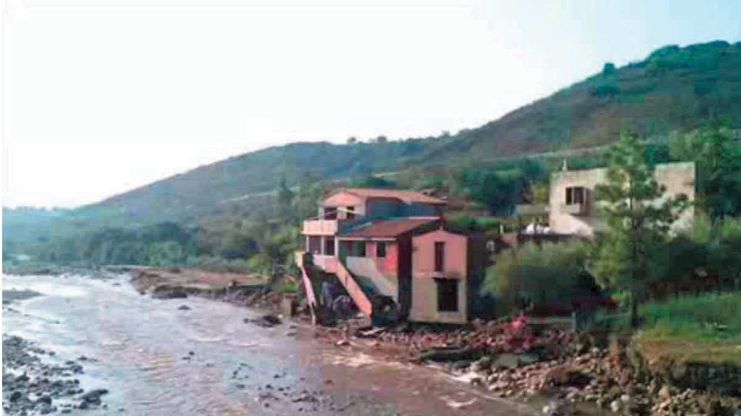
Figura 15 - Edifici a valle del ponte di Berruiles dopo l'alluvione del 2010
