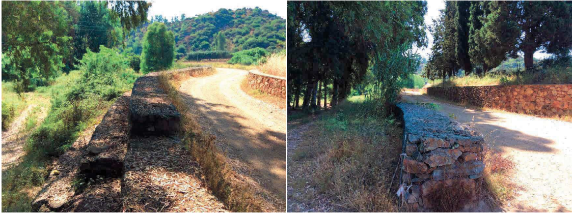
Figura 33 - Ballao - Difesa spondale da potenziare
