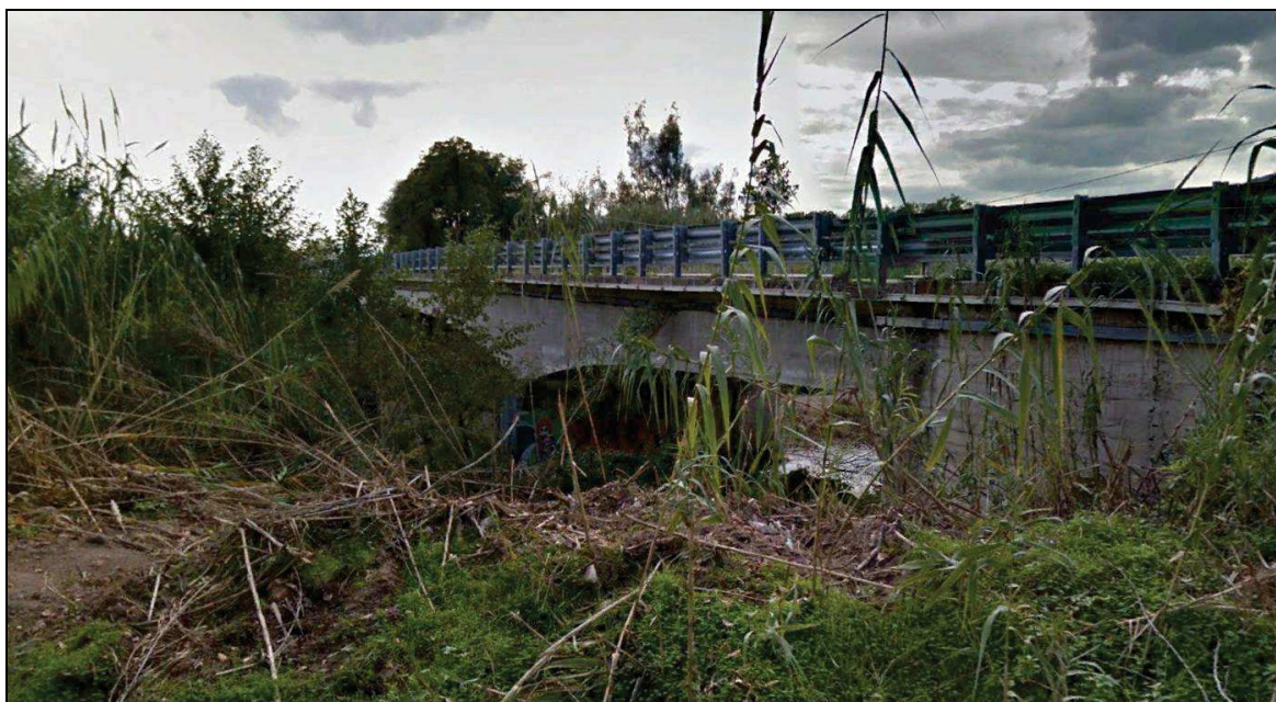
Figura 1.2 – Ponte S.S.125 Orientale Sarda
