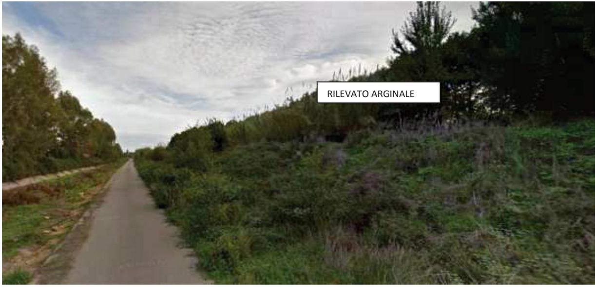
**Figura 6.3 – Rilevato arginale sinistro zona foce (si noti il pessimo stato di manutenzione)**
