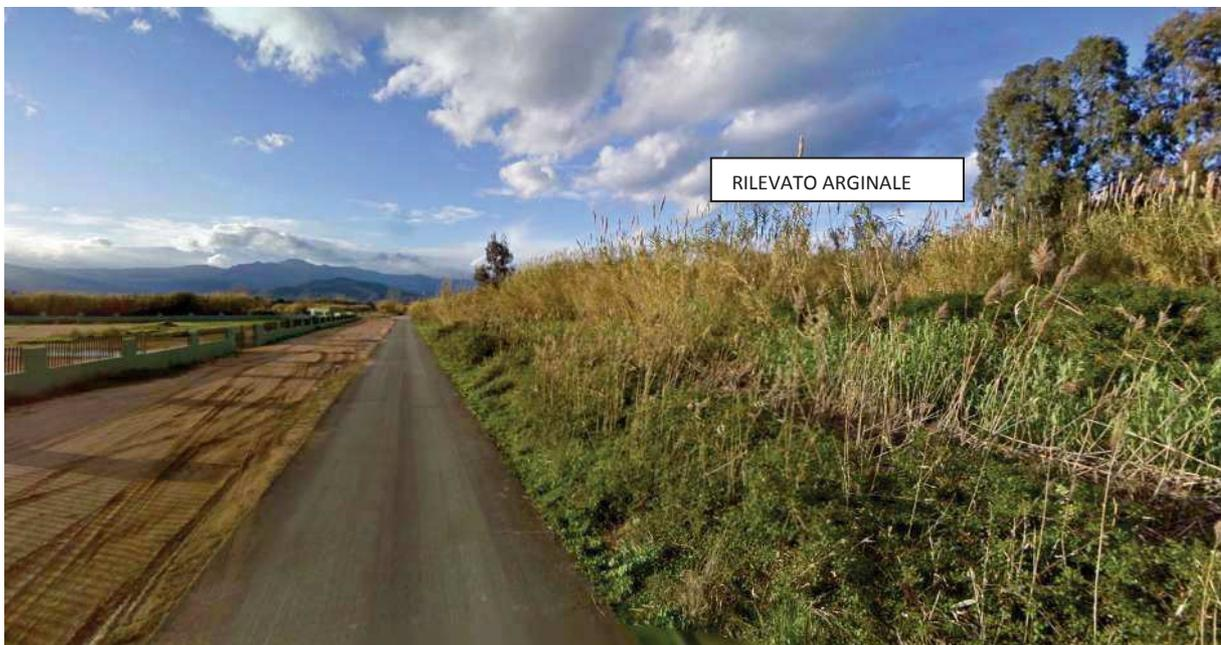
**Figura 6.4 – Rilevato arginale destro zona foce (si noti il mediocre stato di manutenzione e l'assenza del colatore dx)**
