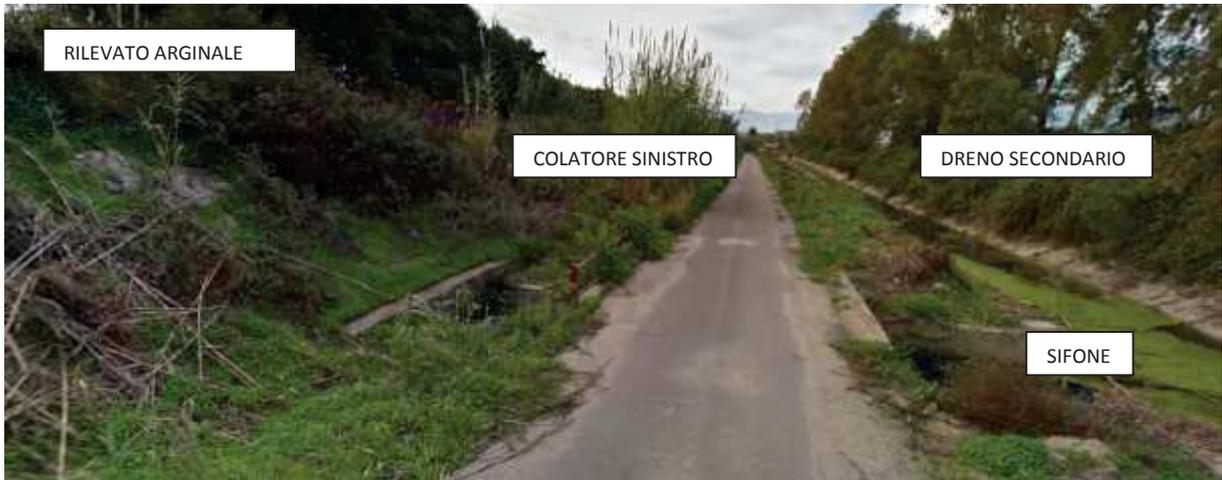
Figura 6.6 – Sistema di raccolta acque in sponda sinistra (il canale secondario proviene dall'abitato di Lotzorai).
