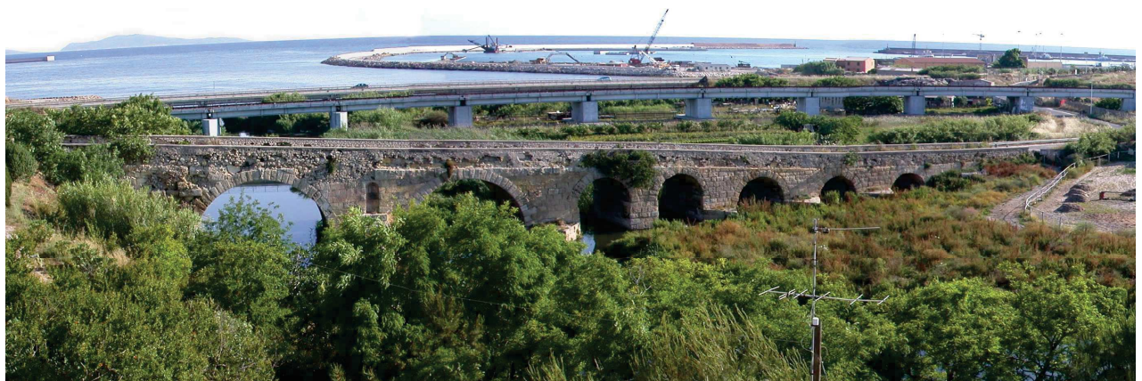
Figura 6-2 Ponte Romano Stato attuale
