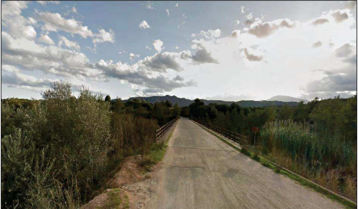
Figura 1.4 – Ponte strada comunale is Fossas - loc. Masone Maore
