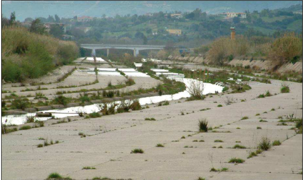
Figura 1.2 – Ponte S.S.125 Orientale Sarda
