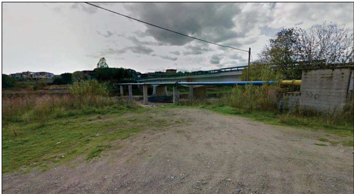
Figura 4.7 – Ponte sulla SS 125 e Ponte tubo
