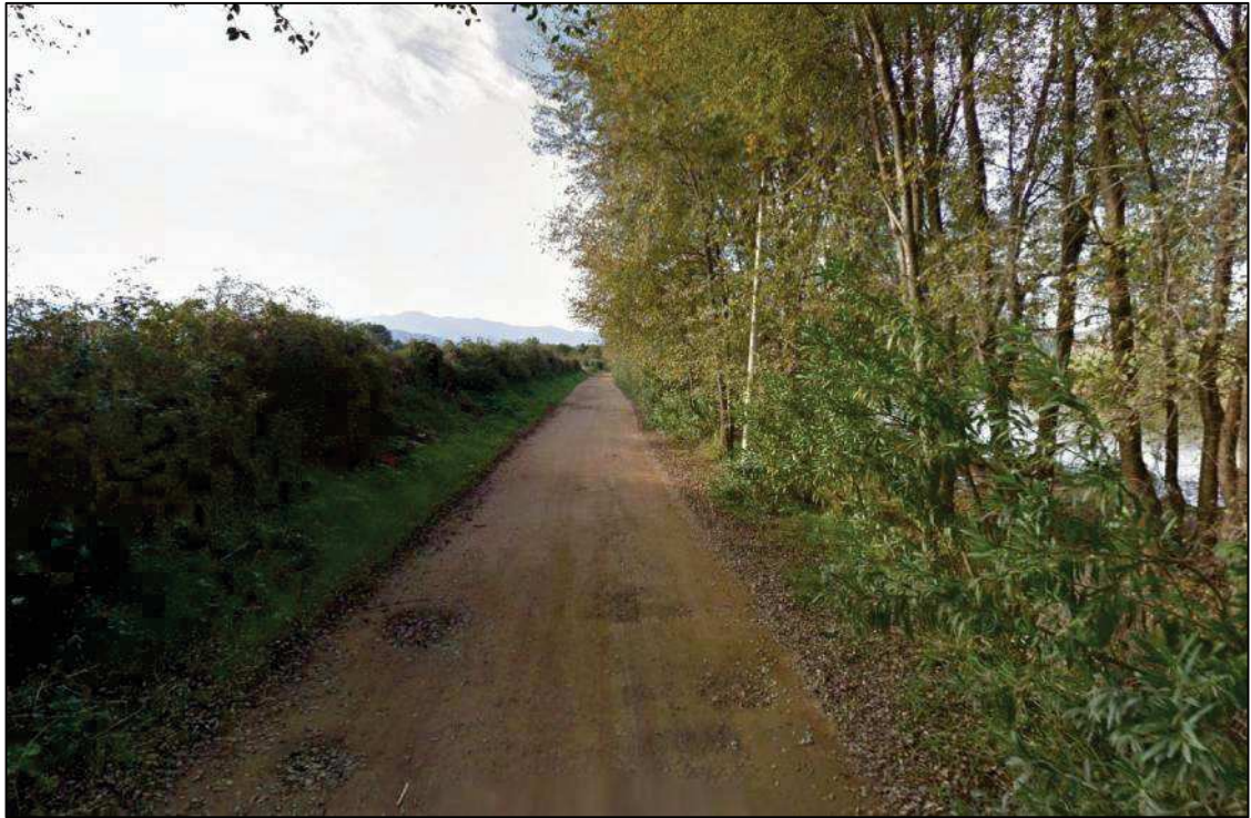
Figura 6.5 – Argine destro Rio Pramaera
