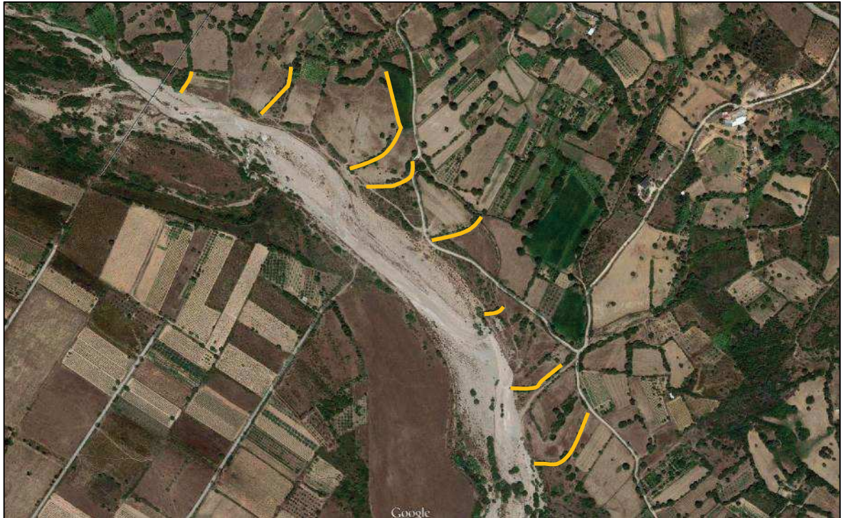
Figura 6.1 – Pennelli a protezione delle aree agricole in sponda sinistra (circa 3 km a monte della SS 125).
