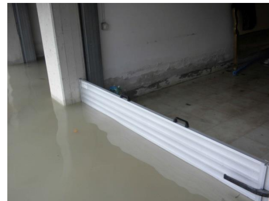
Misure di autoprotezione locale: paratie mobili anti-allagamento
