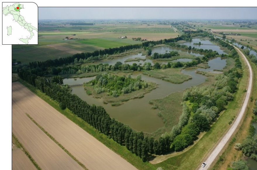
Figura 25) Impianto di fitodepurazione Ca' di Mezzo (VE)
