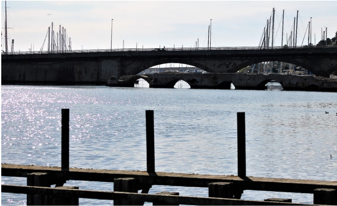
Figura 12) Infrastrutture nel porto-canale di Fertilia (SS)
