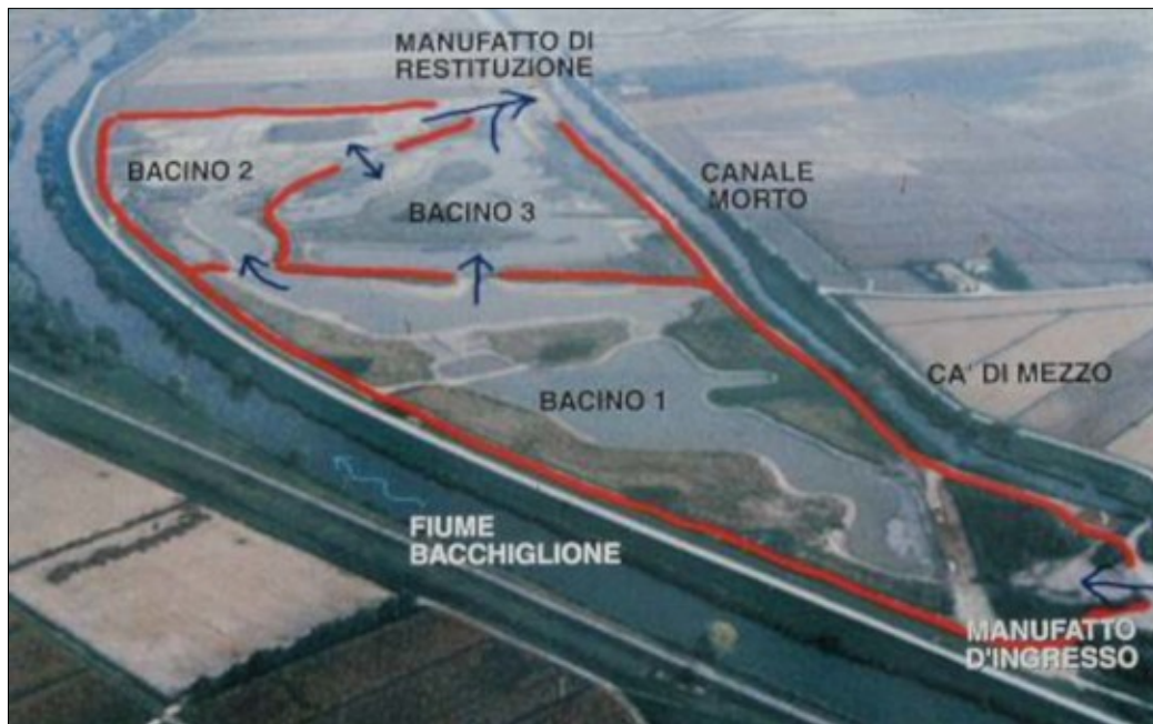
Figura 26) Il percorso idraulico dell'area umida di Ca di Mezzo (VE)
