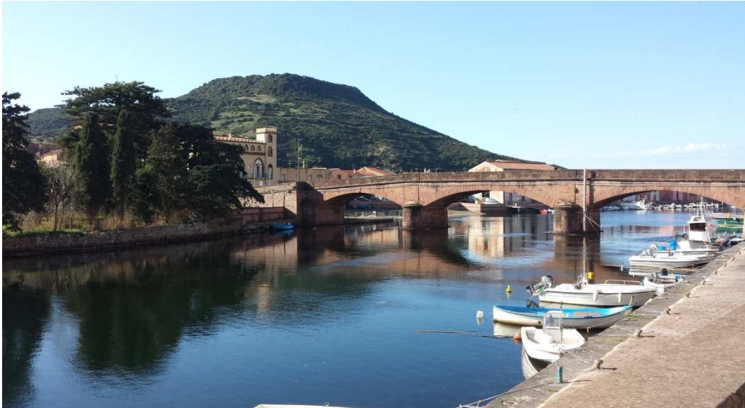
Figura 1.3 – Ponte Vecchio Loc. S. Antonio
