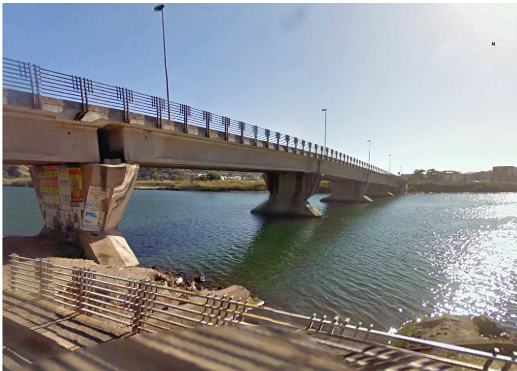
Figura 1.4 – Ponte nuovo SP 49
