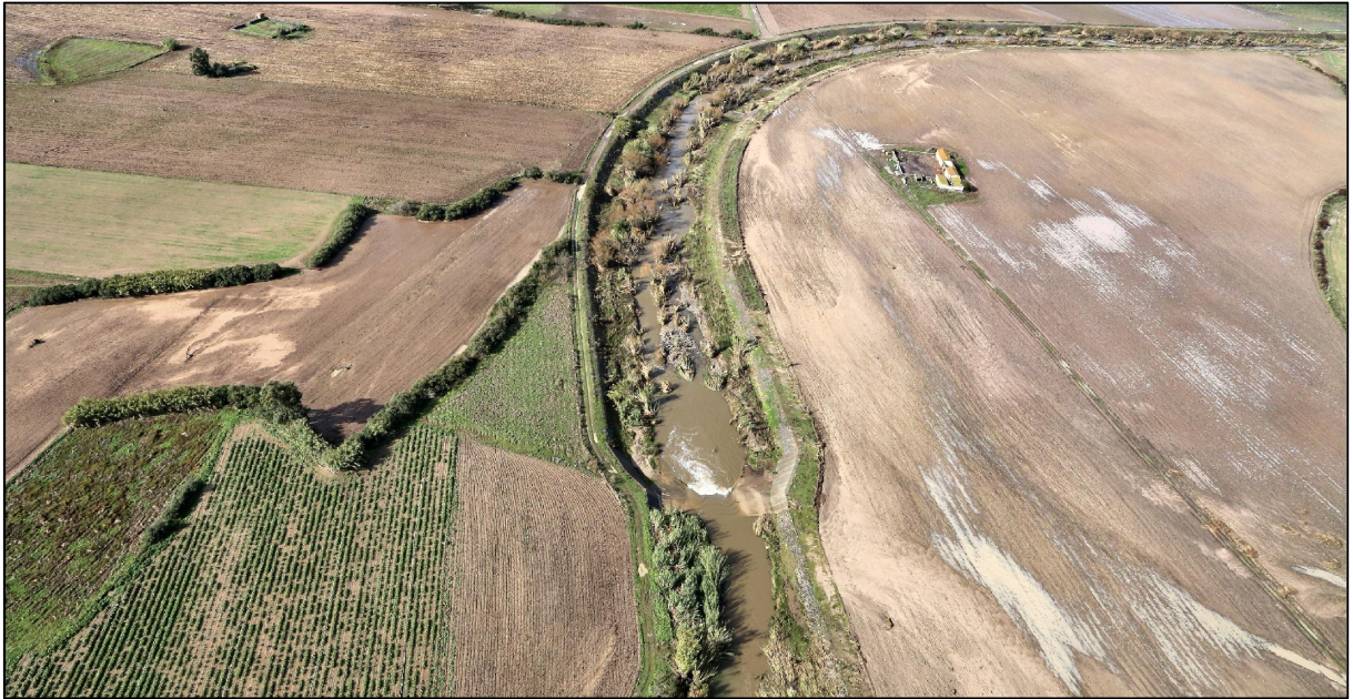
Figura 19 – Tratto intermedio – Sistemazione a valle della confluenza con il Flumini Bellu
