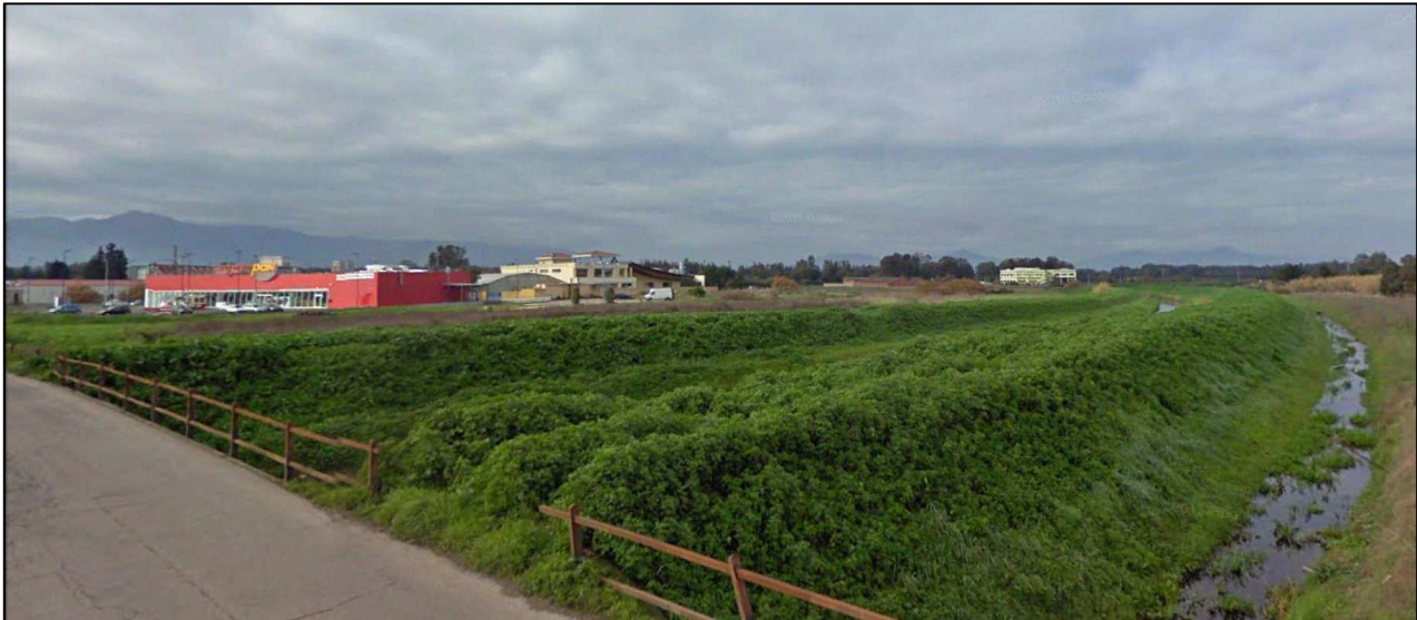
Figura 35 –Ponte “San Gavino Sud” – Vista sul ponte
