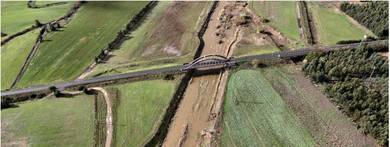
Figura 24 – Ponte sulla S.S. 126
