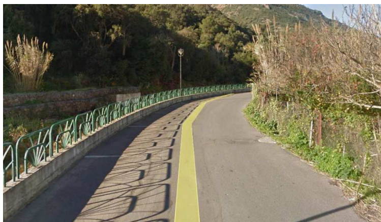
Figura 1.7 – Muretto di recinzione stradale
