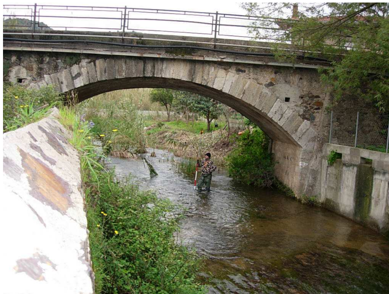
Figura 1.3 – Ponte SS 126 sul Rio Mannu
