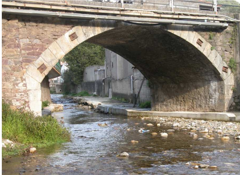
Figura 1.11 – Ponte Via V. Emanuele
