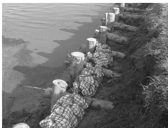
Figura 7.15 – Esempio di intervento di stabilizzazione con pali infissi sul piede della sponda e burghe di consolidamento (da completare con il riempimento e la riprofilatura della sponda)
