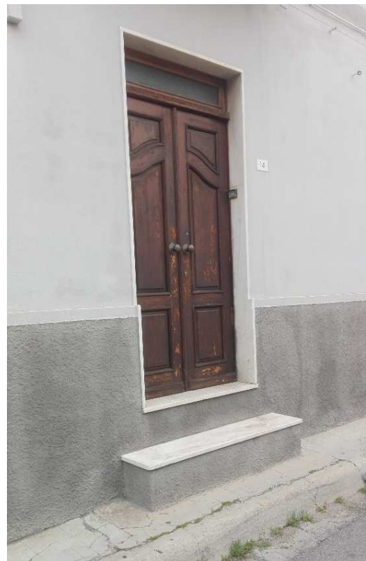
sopraelevazione del piano di calpestio
