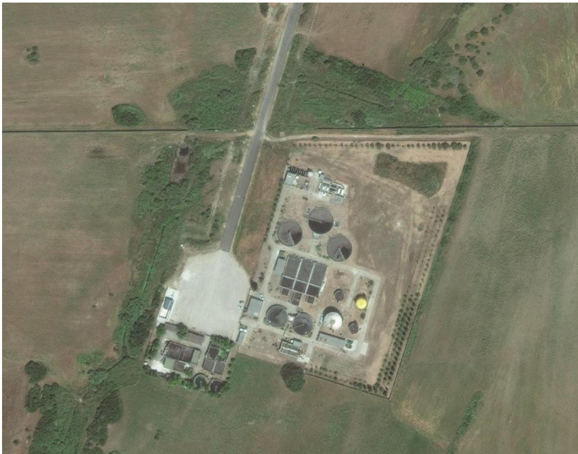
Il depuratore di Alghero San Marco
